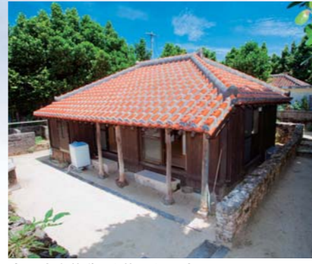
古民家を修復・改修した民宿
