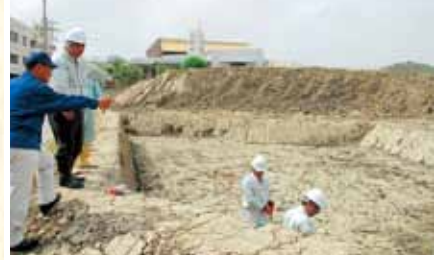
3/23 仲井眞知事は、県が不発弾探査事業で発注した八重瀬町字宜次地内の現場を視察しました。
