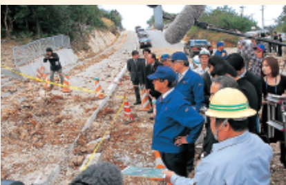
1/16 1月14日に糸満市小波蔵の水道工事現場で起こった不発弾爆発事故現場等を視察し、関係者から事故の状況などについて説明を受けました。
