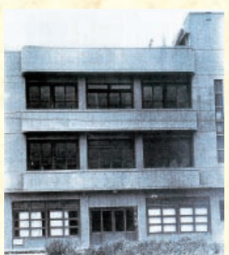
戦災を免れた円山号デパート（昭和27年） 第1回から第4回までの立法院議事堂が開催された。
