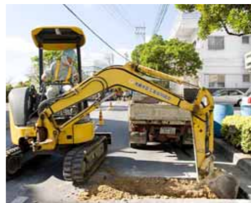
水道管をつなぐため、道路を掘り起こす金城さん
