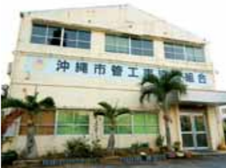
組合では上下水道の 給排水設備工事などを行う
