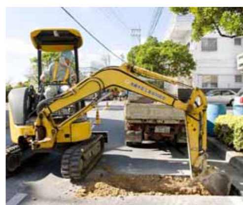
水道管をつなぐため、道路を掘り起こす金城さん
