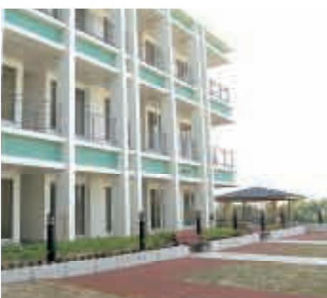
3,4階の屋根面に中庭をつくり緑化を図りました。
