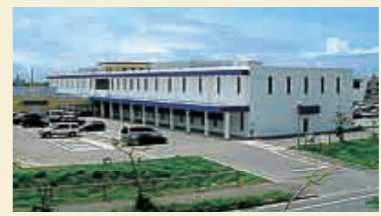
名護市マルチメディア館 企業の創業時における設備投資などの初期投資の軽減を目的として作られたベンチャー企業のためのインキュベーション施設で、特区に進出した情報・金融関連業も入居しています。
