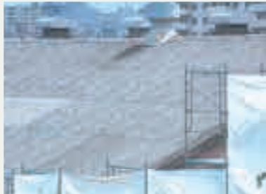
波形スレート(成形板アスベスト) (写真提供:中皮腫・じん肺・アスベストセンター)
