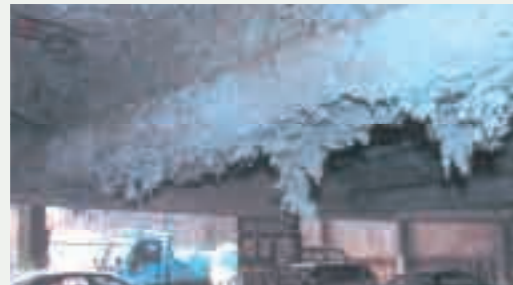
クロシドライド吹き付け(吹き付けアスベスト)-劣化し垂れ下がった状態(写真提供:中皮腫・じん肺・アスベストセンター)
