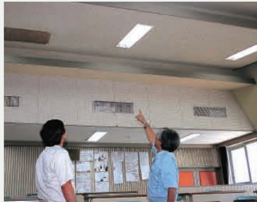
天井部分にアスベストを含む吹き付け材が使用されていないか学校施設を調査
