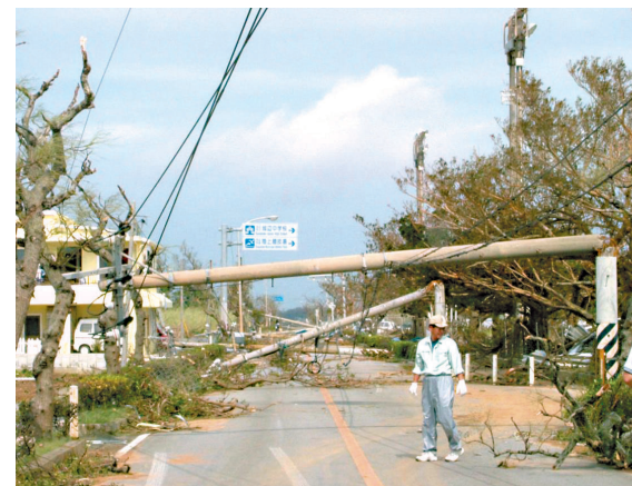
平成15年の台風14号による電柱倒壊被害(宮古島)
