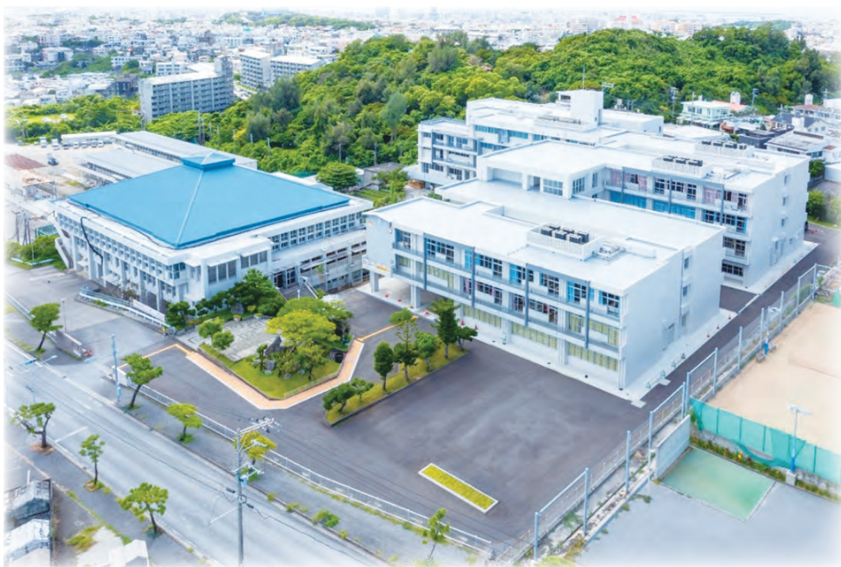
開邦高校・中学校校舎改築工事（第2期）
