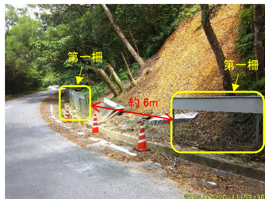
写真3 抜け対策を行う3地点（簡易柵新規設置）
