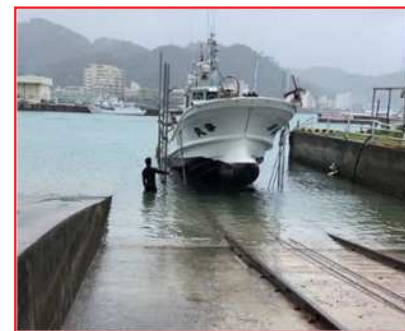
船揚場の先端水深が浅く、干潮時には潮待ちにより上下架作業時間が制限され、荒天時の陸上避難の支障となっている。
