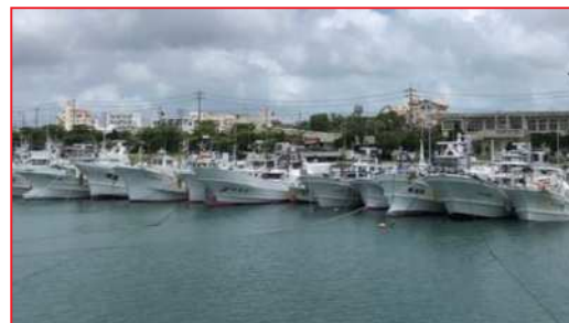
荒天時の安全係留に必要な係留施設が不足しており、漁船の輻輳による接触被害が生じている。
