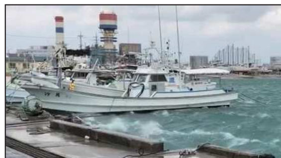
荒天時の泊地の様子。静穏度が悪いので漁船が動揺し、安全性が確保されていない
