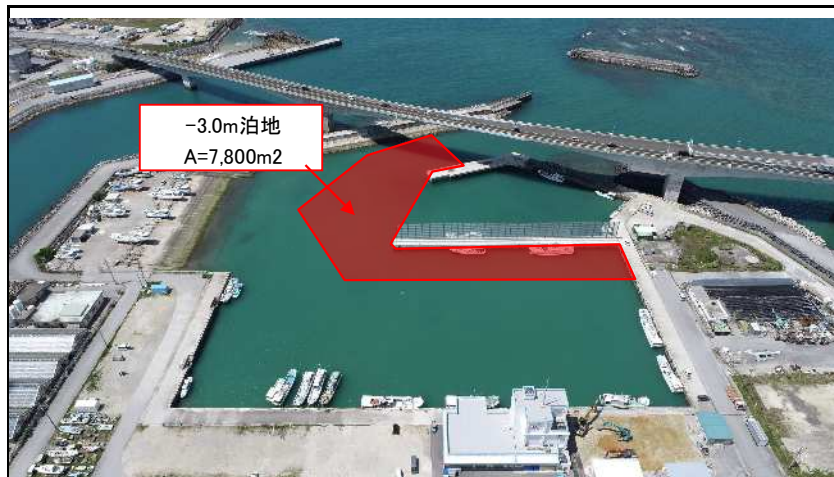
施設名: -3.0m泊地 A=7,800m 2 現場状況
