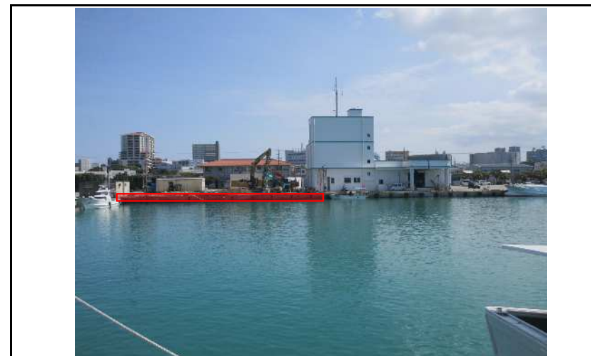
施設名: 南岸壁(改良) L=43.8m 現場状況
