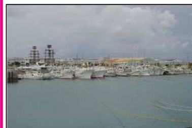
台風に備えた避難係留状況 (強風を遮る施設がなく、漁船が動揺し、 十分な安全性が確保されていない)
