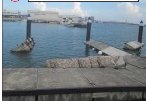
① 台風時の浮桟橋被災状況
