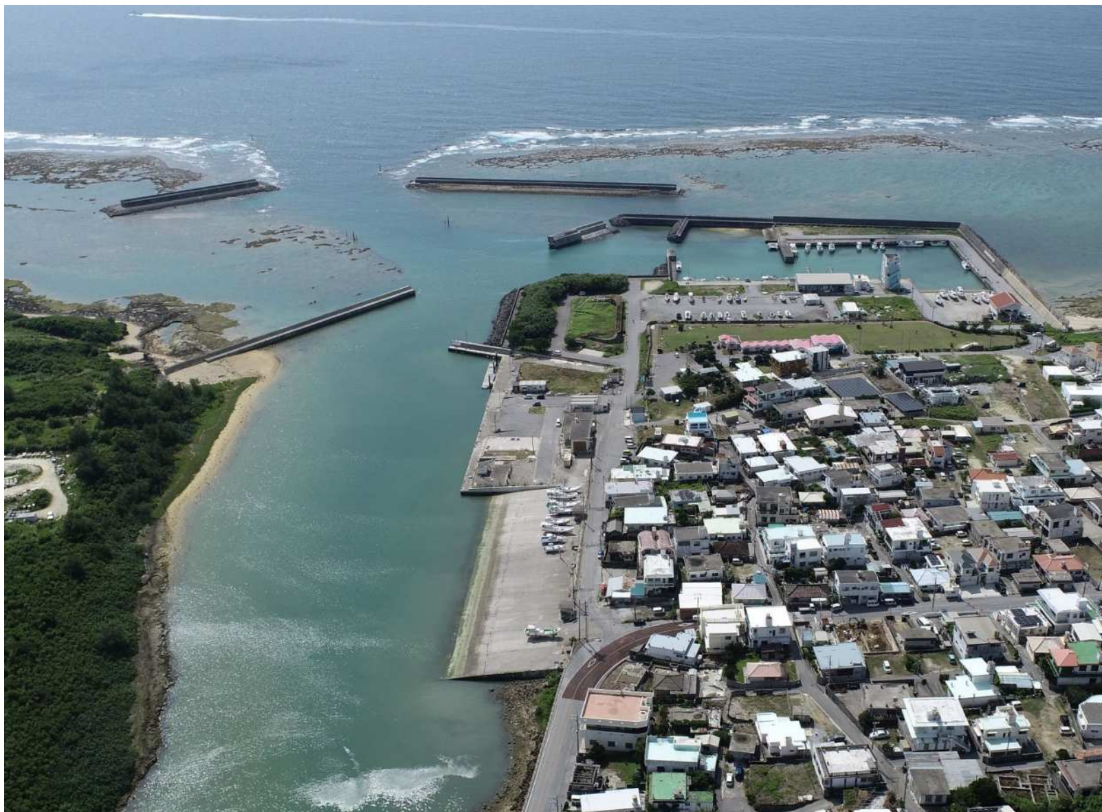
港川漁港 第1種 沖縄県管理 昭和43年指定 令和4年撮影
