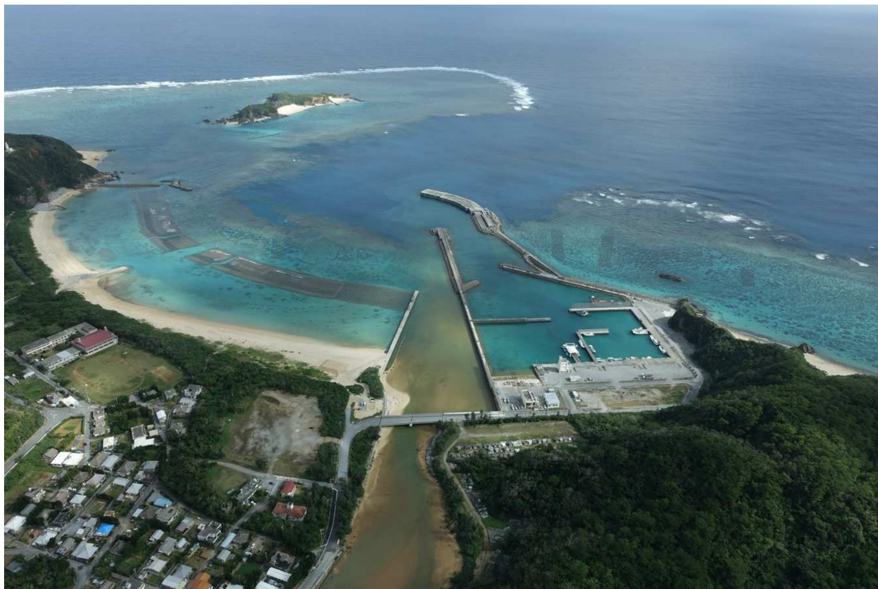
安田漁港 第4種 県管理 昭和47年指定 平成29年撮影
