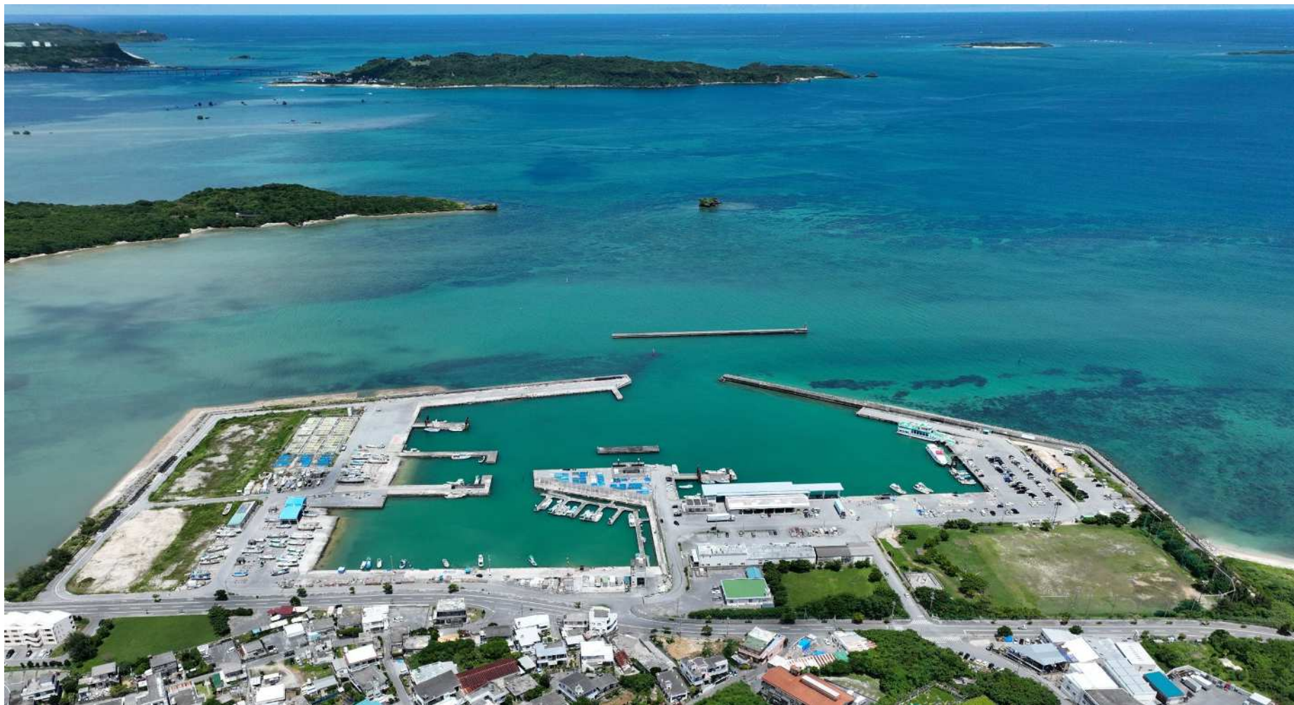
平敷屋漁港 第2種 県管理(うるま市) 令和3年8月撮影
