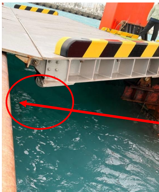
接続渡部ローラー架台の欠損
