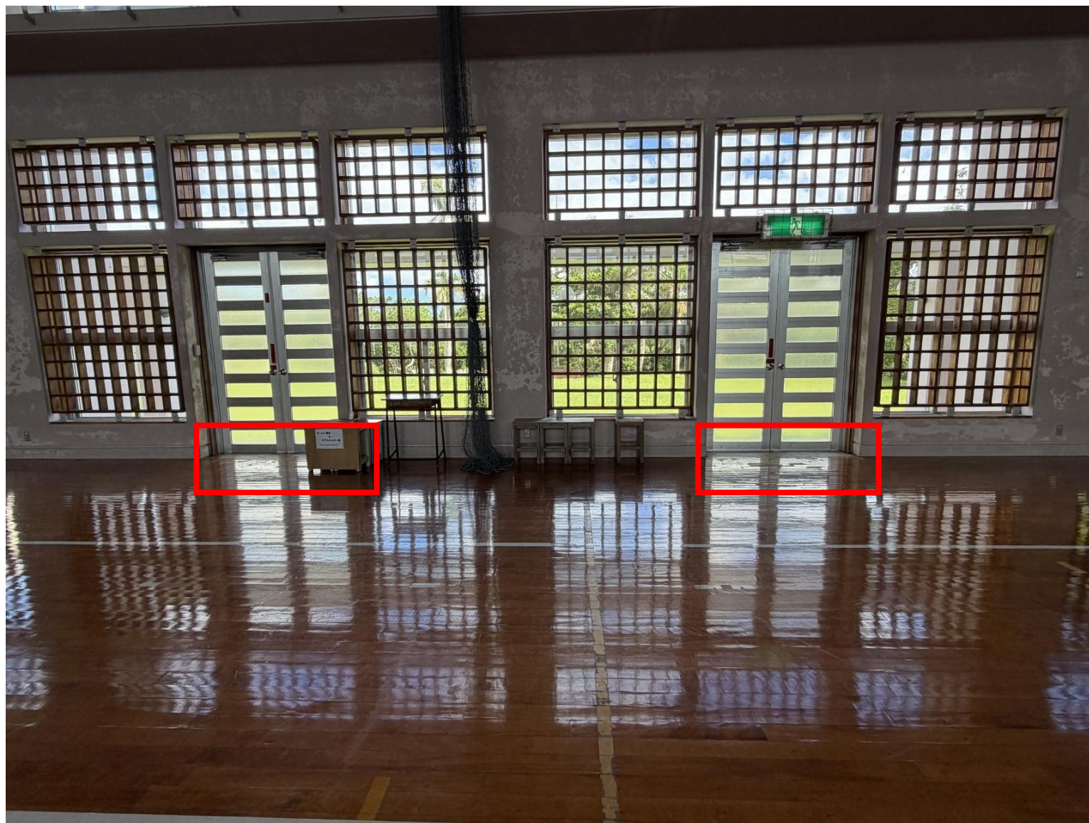
業務仕様書（４）既存床補修箇所
