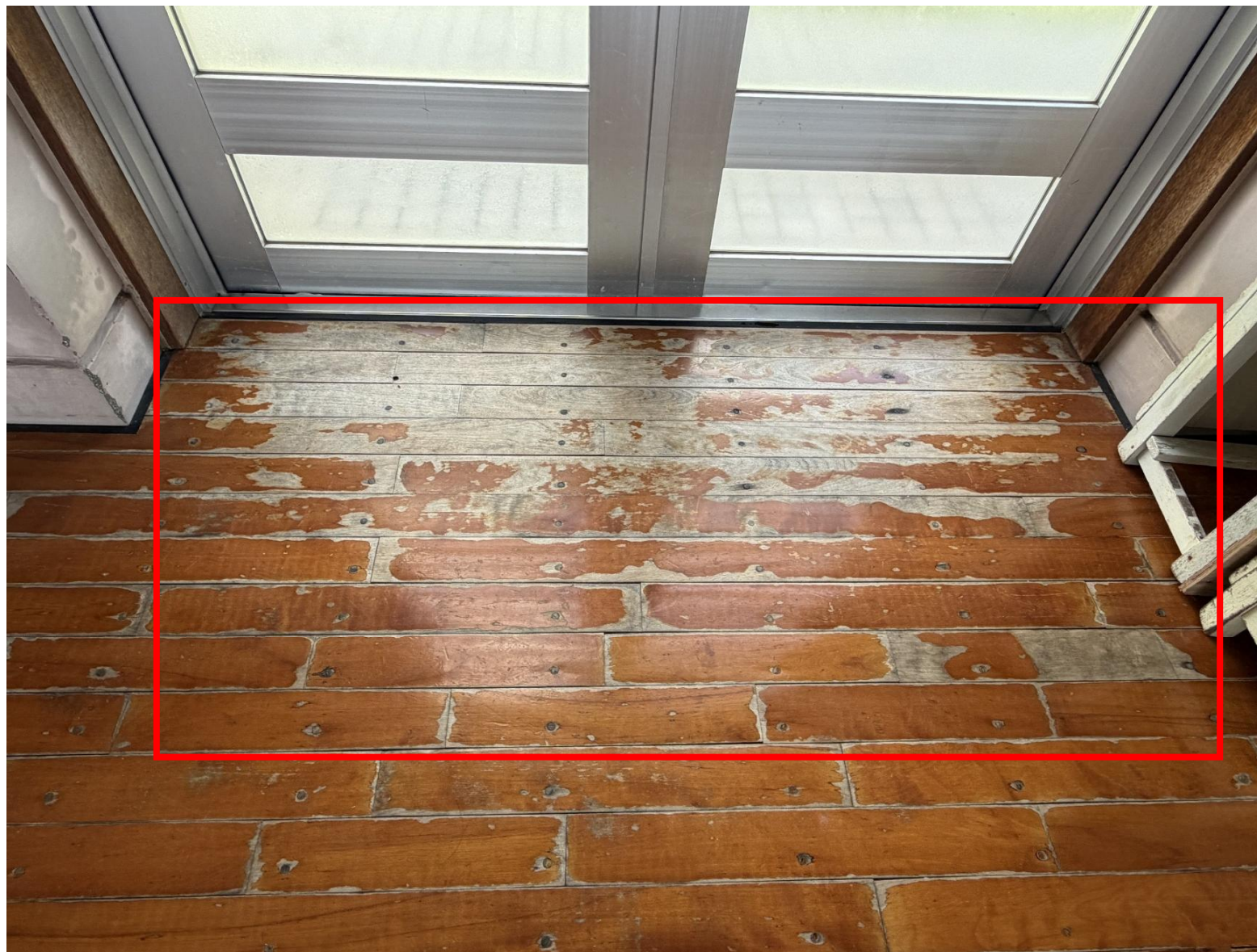
業務仕様書（4）既存床補修箇所（玄関側）
