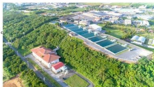
袖山浄水場（宮古島市水道部HP）
