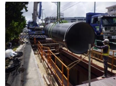
耐震管布設工事
