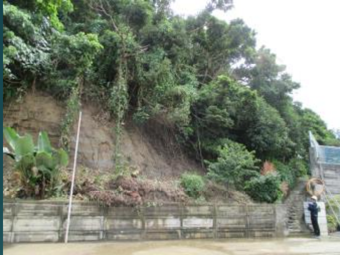
大雨で崩れた森林の調査
