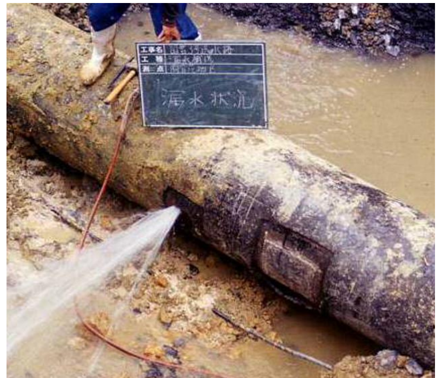
農業水利施設の漏水状況
