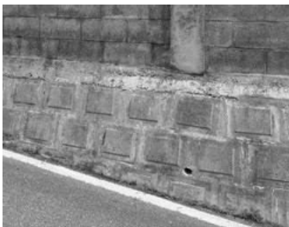
間知ブロックの擁壁
