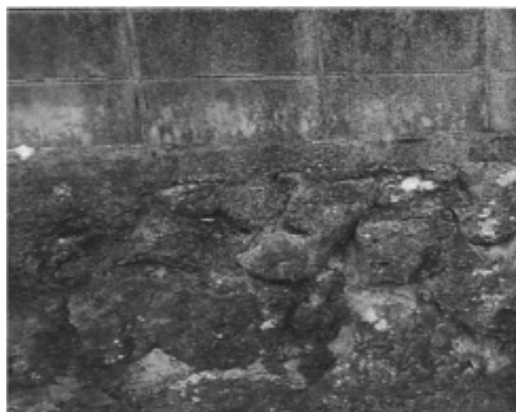
自然石積みの擁壁
