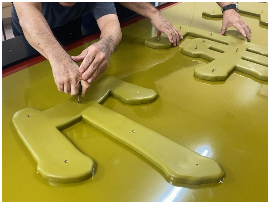
題字貼り付け作業
