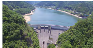
大阪府 淀川ダム
