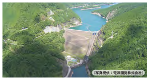
高知県 魚梁瀬ダム
