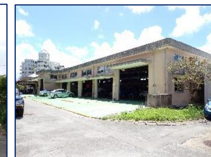
自動車整備科実習棟 (築45年)
