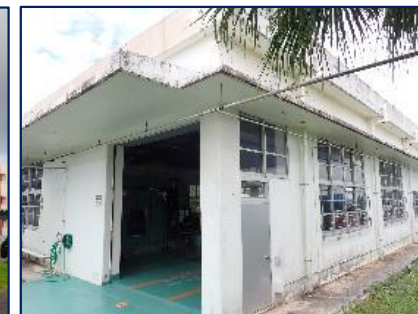
自動車整備科第1実習場 (築50年)
