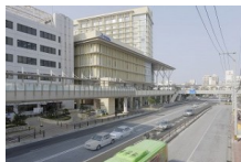
⑬モノレール旭橋駅からの直結通路（全体）
