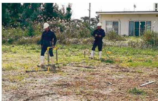
水平磁気探査の様子
