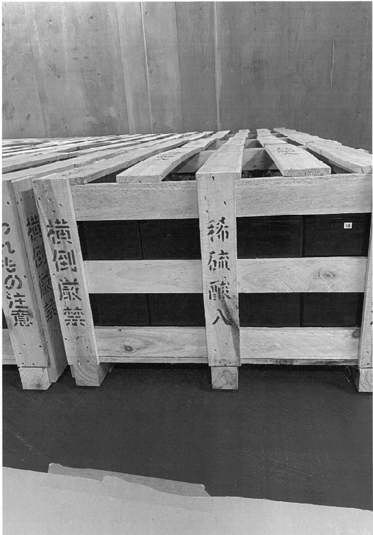
処分対象UPS蓄電池の保管写真
