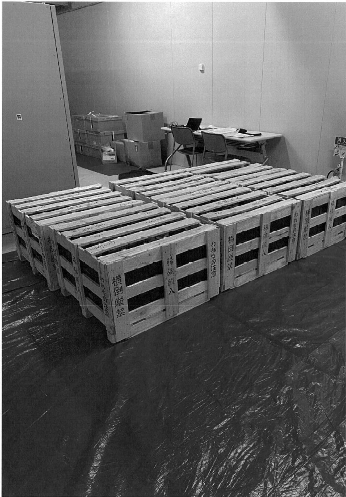
処分対象UPS蓄電池の保管写真
