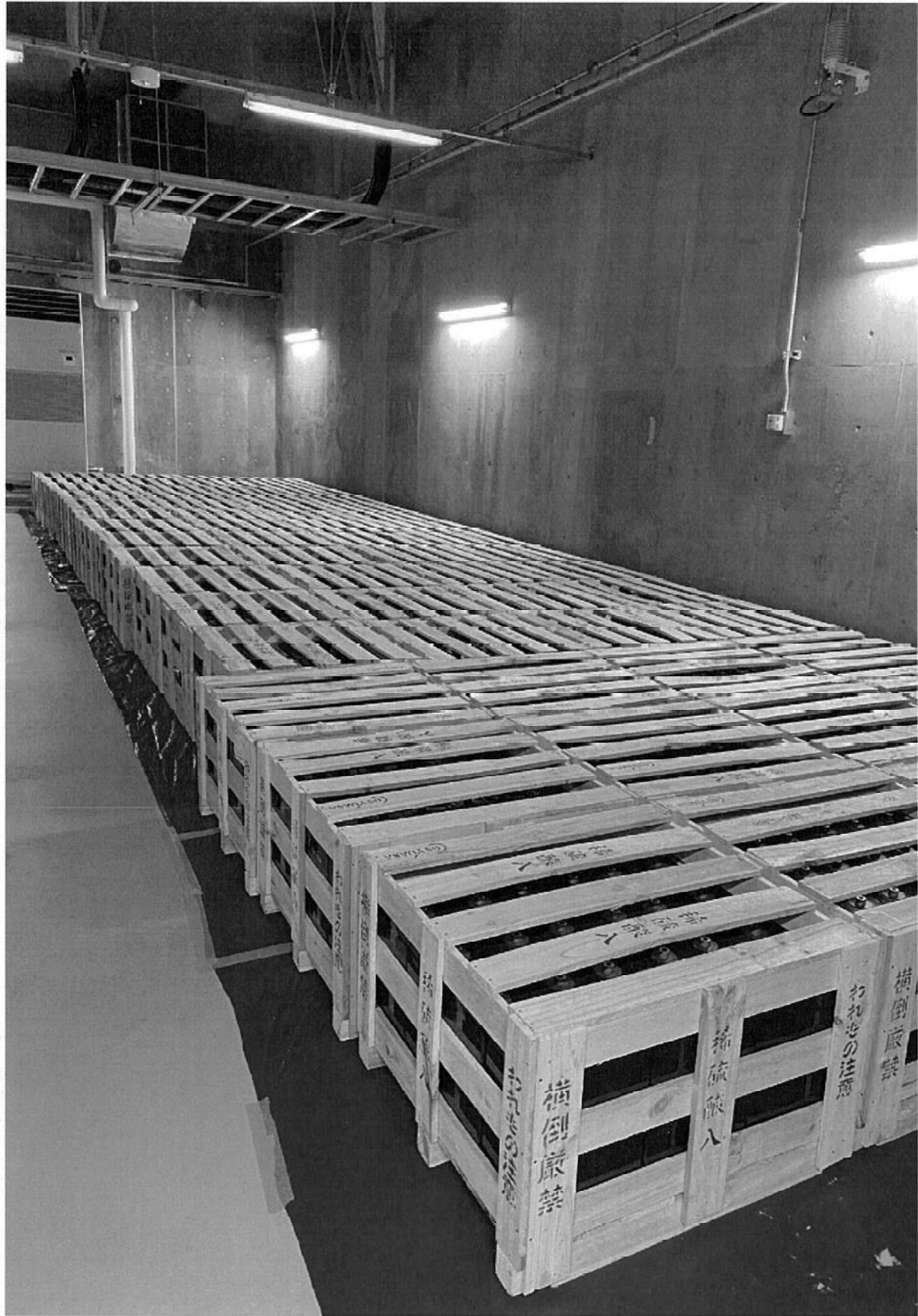
処分対象UPS蓄電池の保管写真
