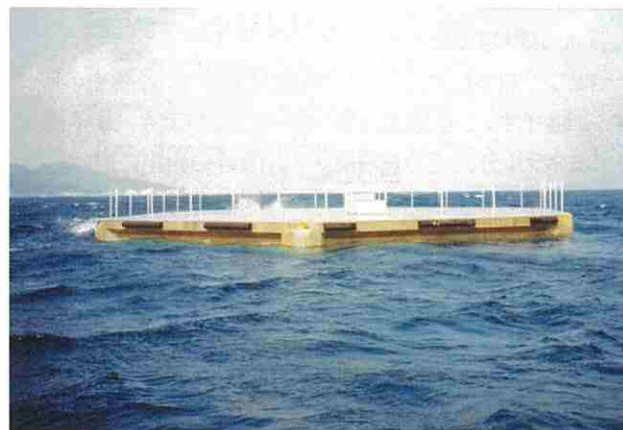
図3.敷設したヘキサフロート
