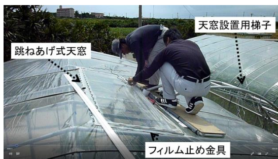
図4 天窓設置作業の様子
