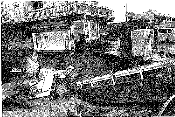
東村での大雨災害被害状況
