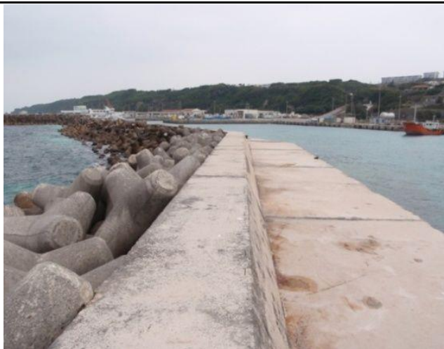
施設名 : 東防波堤(消波ブロック復旧) L=18.7m 平成22年3月撮影
