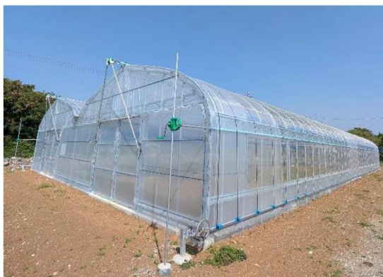
強化型耐候性施設（強化型パイプハウス） （令和5年度沖縄型耐候性園芸施設整備事業）
