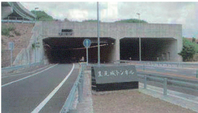
豊見城トンネル
