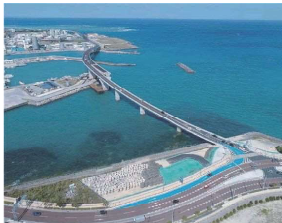
国道58号 浦添北道路
