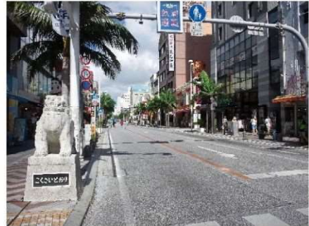
○街路整備事業（国際通り）
