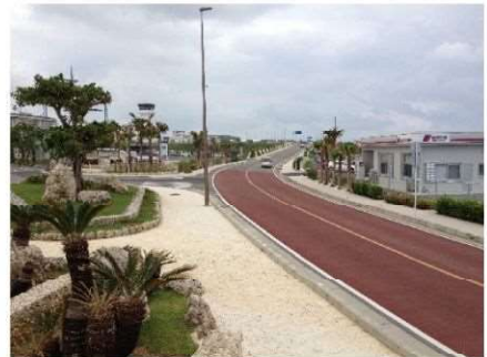
○離島の道路・街路整備事業（新川白保線）
