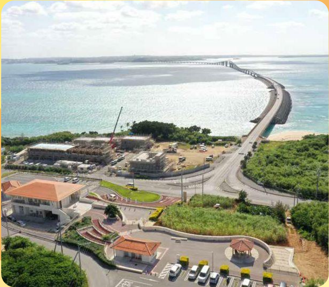
一般県道 平良下地島空港線（伊良部大橋）
