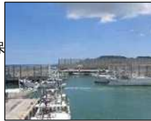
防風柵整備による 安全係留
