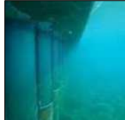
腐食部分を補修し ペトロラタム被覆に よる腐食防止対策
