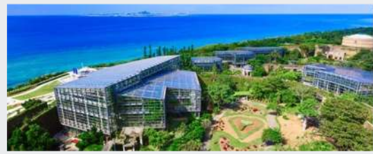
熱帯ドリームセンター 沖縄県国頭郡本部町字石川424
