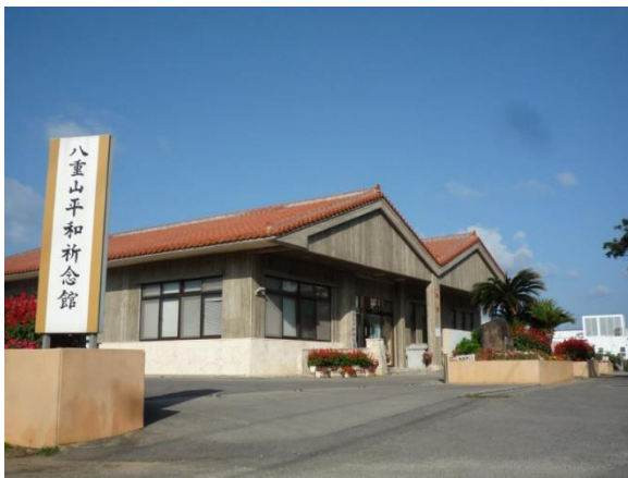
八重山平和祈念館 外観
