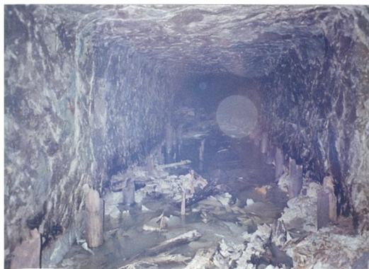
16 第2坑道(泥岩) 17 破損した坑木が残る
