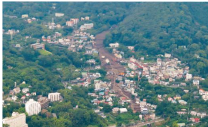
写真 R3.7月静岡県熱海市 死者28名 住宅被害98棟
