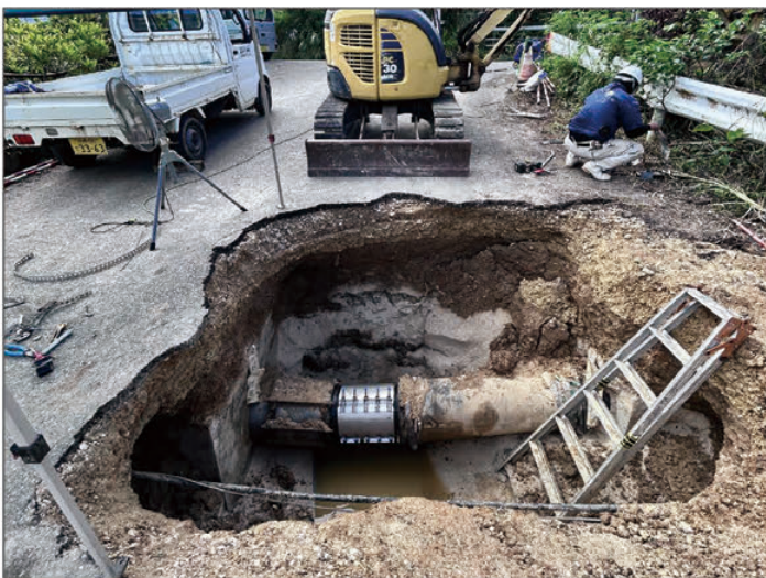
漏水対策工事
