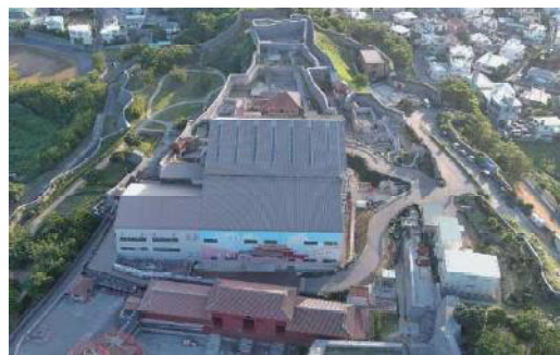
現在の首里城（令和5年11月1日） 工事中の正殿が風雨や埃等の影響を受けないように、 仮設施設（木材倉庫・原土場・素屋根）の中で工事が進められています。
