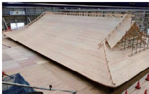
復元中の正殿（令和6年5月27日） 屋根廻りが組みあがり、上棟を迎えました。 令和6年度は瓦葺きや漆塗装の作業が始まり、工事の最盛期となります。
