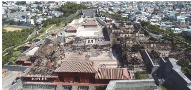
火災後（令和元年11月1日）
