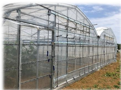
巻上機を2段に設置
