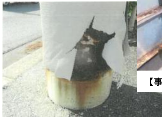
【事例：宜野湾西原線（支柱基部）】
