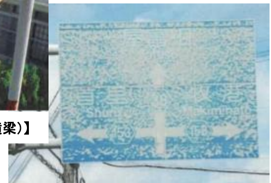
【事例：浦添西原線（標識板）】
